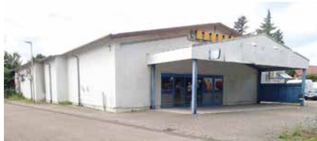
Alte Markthalle Legelshurst
