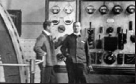
Bereits schon während des Mühlenbetriebs montierte man 1901 eine Francis-Turbine, für die 1903 eine kleine Schaltanlage errichtet wurde. Als dann 1911 zwei neue Francis-Turbinen eingebaut wurden, war ein richtiges Elektrizitätswerk entstanden, das 1913 als "Rheinelektra-Schuckart AG" firmierte. Bis 1988 waren diese beiden Turbinen in Betrieb. Dann wurden sie (1988 die erste, 1996 die zweite) ausgewechselt. Die erbrachte Leistung (zusammen ca. 500 Kilowatt) konnte aber durch die
