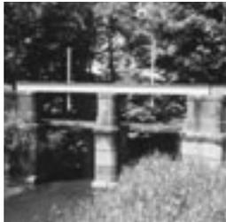
Das bedeutendste Wehr im Unterlauf der Kinzig liegt auf Gemarkung Willstatt bei der Straße nach Eckartsweier. Es wurde von 1956 bis 1958 erbaut und ist ausgerüstet mit zwei je 22 m breiten und 3,7 m hohen „Fischbauchklappen“, die vollständig umgelegt werden können. Mit diesem Wehr wird sichergestellt, dass der alte Kinziglauf durch Willstatt mit dem dortigen Elektrizitätswerk ausreichend mit Wasser aus dem neuen Kinzigbett gespeist wird.
