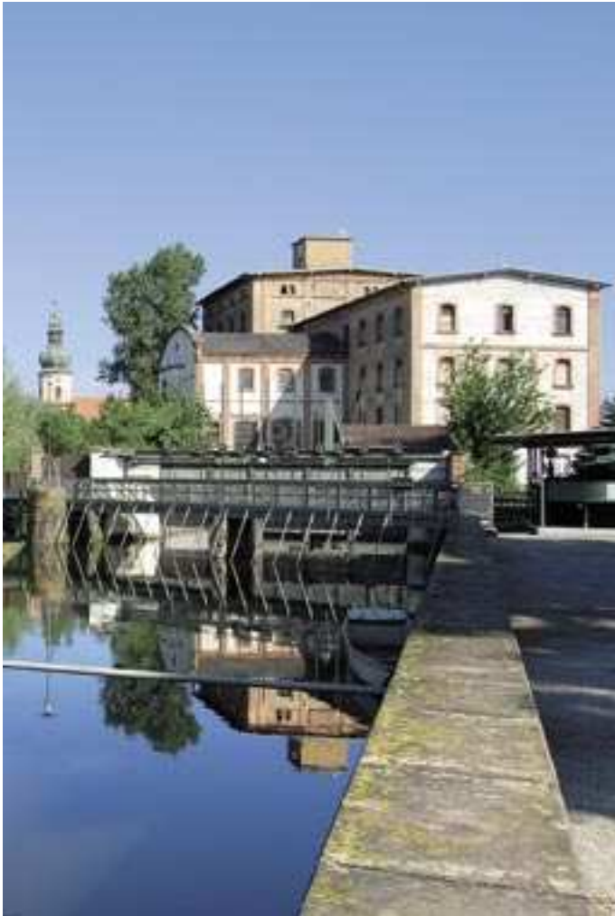
Industriedenkmal: Das ehemalige Mühlengebäude soll saniert und für andere Zwecke umgenutzt werden.
